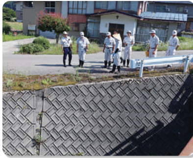
大沢川転落防止柵の設置
