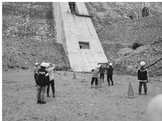
堤体直下の見学もできます
