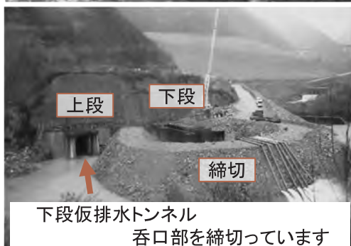
下段仮排水トンネルから排水（工事前）
