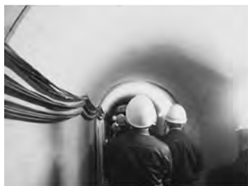
監査廊内の確認
