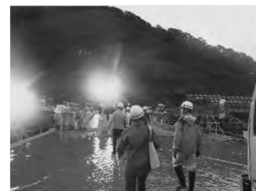
堤体天端の確認
