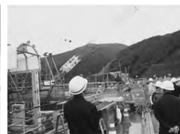
タワークレーンの遠隔操作
