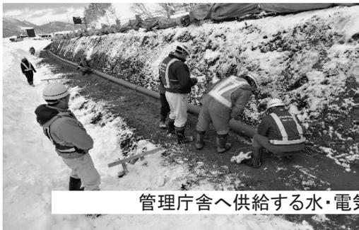
管理庁舎へ供給する水・電気の配管を設置しています！
