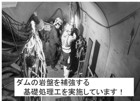
ダムの岩盤を補強する基礎処理工を実施しています！
