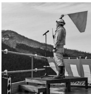
CSG最終打設の号令 (鹿島・前田・竹中土木 特定建設工事共同企業体)
