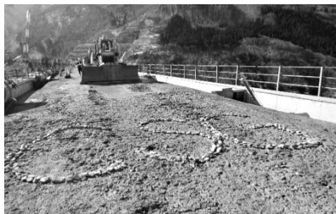
号令を受けダンプ・ブルドーザーによる打設
