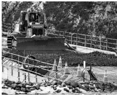
号令を受けダンプ・ブルドーザーによる打設
