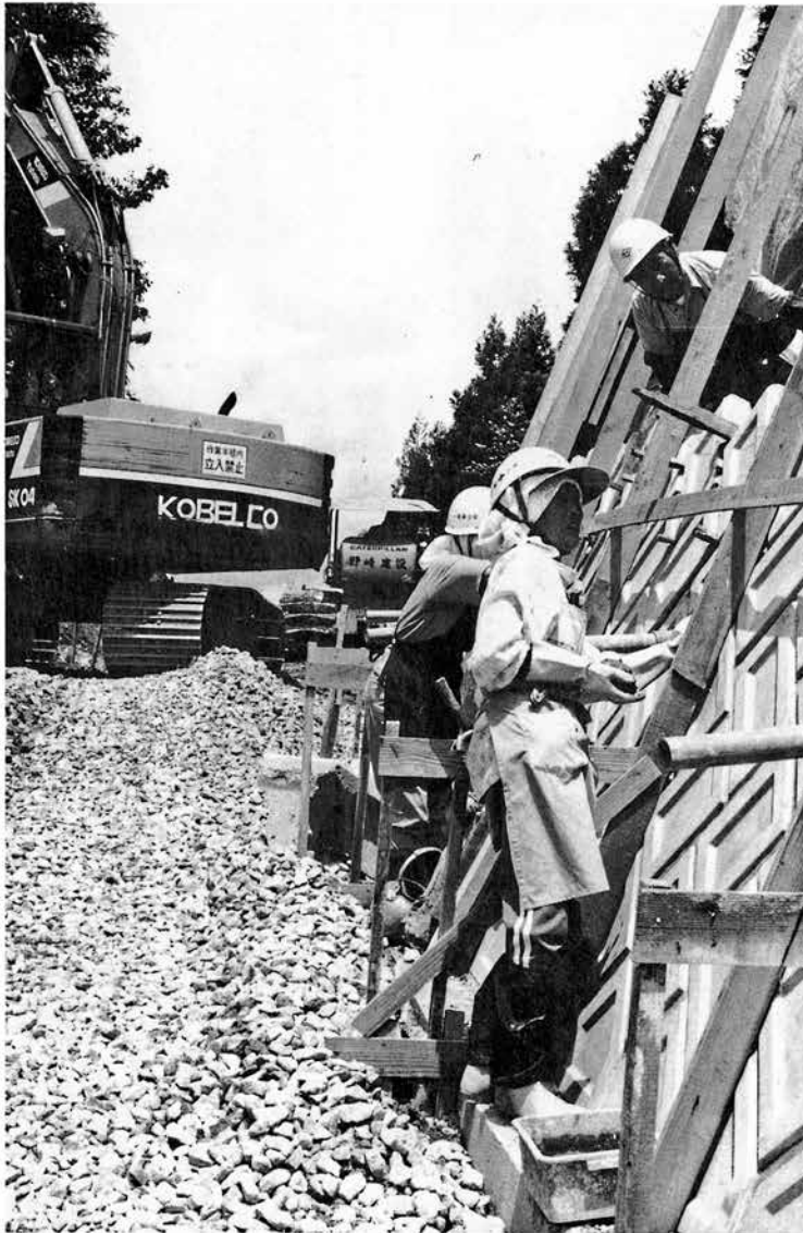
村境付近では山内村側からも工事が進められていた
