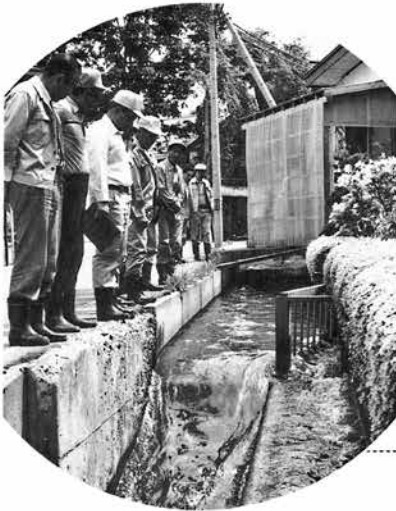
水路拡幅で直角カーブを修正すれば冬の雪づまりが解消するかも (天神林地内伊達堰)
