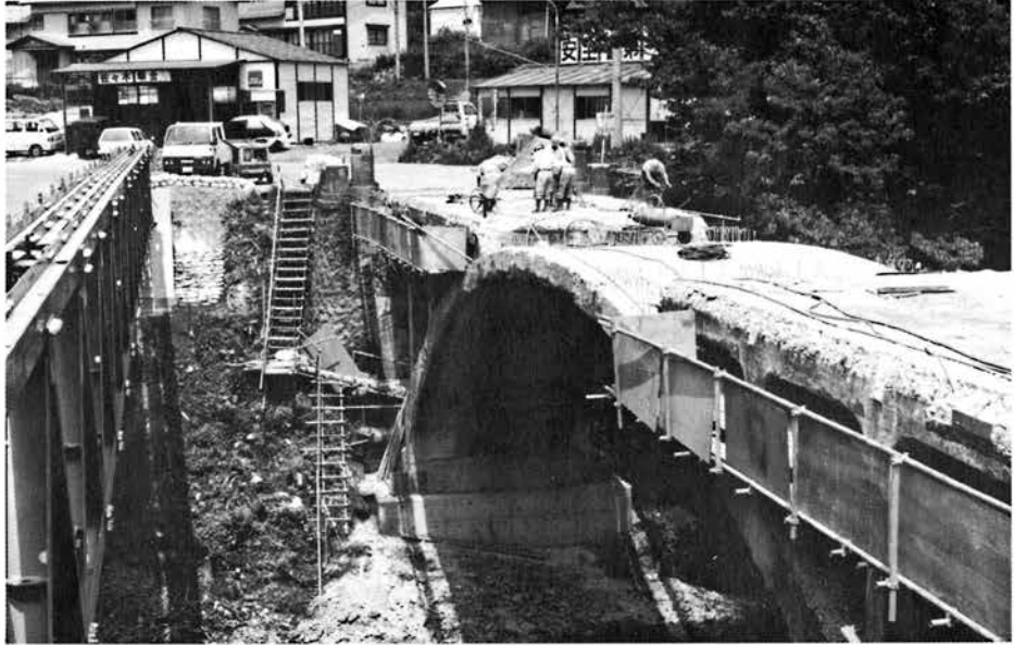
昭和十年に完成したこのコンクリートアーチ橋。半世紀が過ぎ去り今、大改修工事が急ピッチで進められている大橋（田子内橋）
