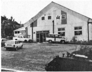
駐車場にもなる栗駒山荘前の取付道路
