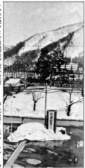
解体中の東成瀬小
