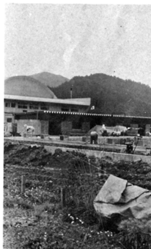
工事が進む東中プール
