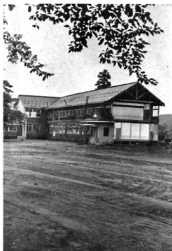
農協倉庫と関連する東小現校舎（1部解体）
