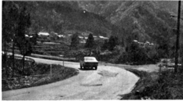
建設省計画は右側へ。部落民は現道の左側を要望。(着沢橋のかしらから西を臨む)
