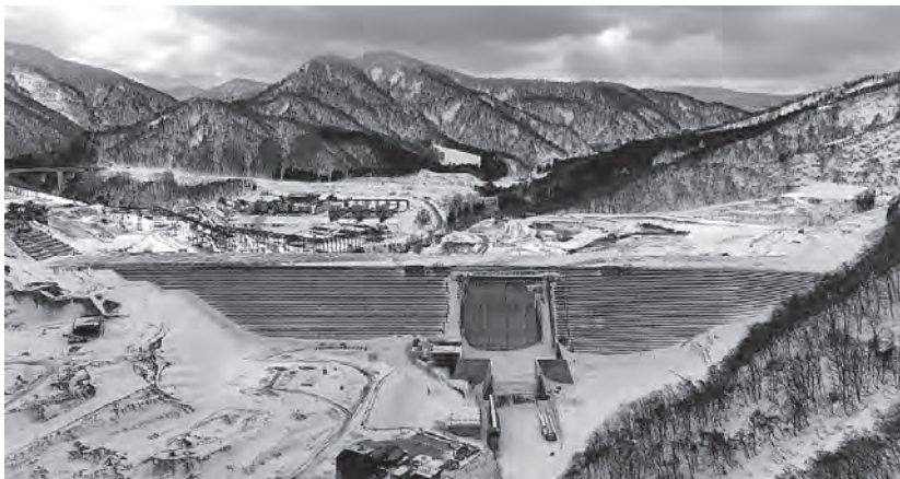
ダム堤体下流から見た状況（2月29日時点）
