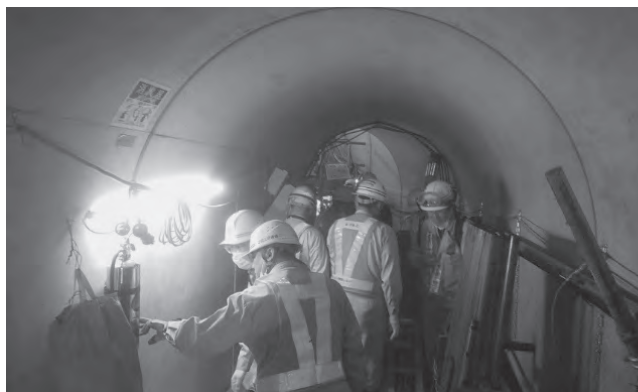
▲監査廊内の安全パトロール実施状況
