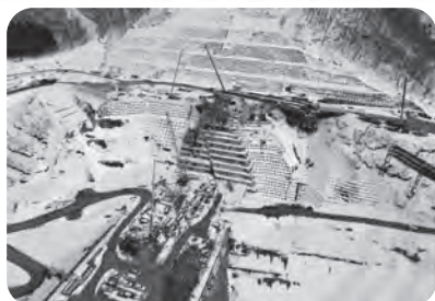
解体が進むベルトコンベアやS P-TOM
