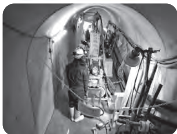
監査廊内での基礎処理施工状況
