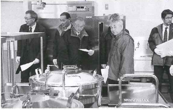
給食センター（調理室）
