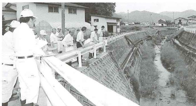
大沢川の土砂・雑草処分（下田）
