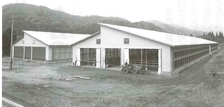
供用開始が近づく大型畜産施設（椿川ウル井地区）
