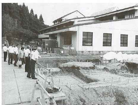
上小阿仁村は基礎工事の段階でした
