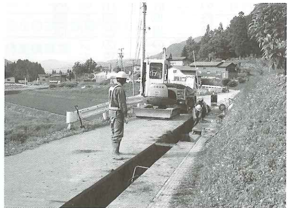
簡易水道事業配水管布設工事（4工区）
