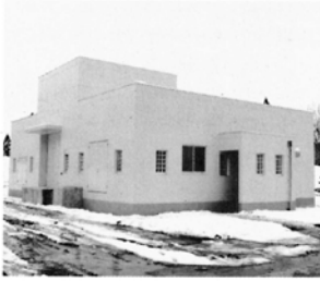
中央監視装置は浄水棟へ設置
