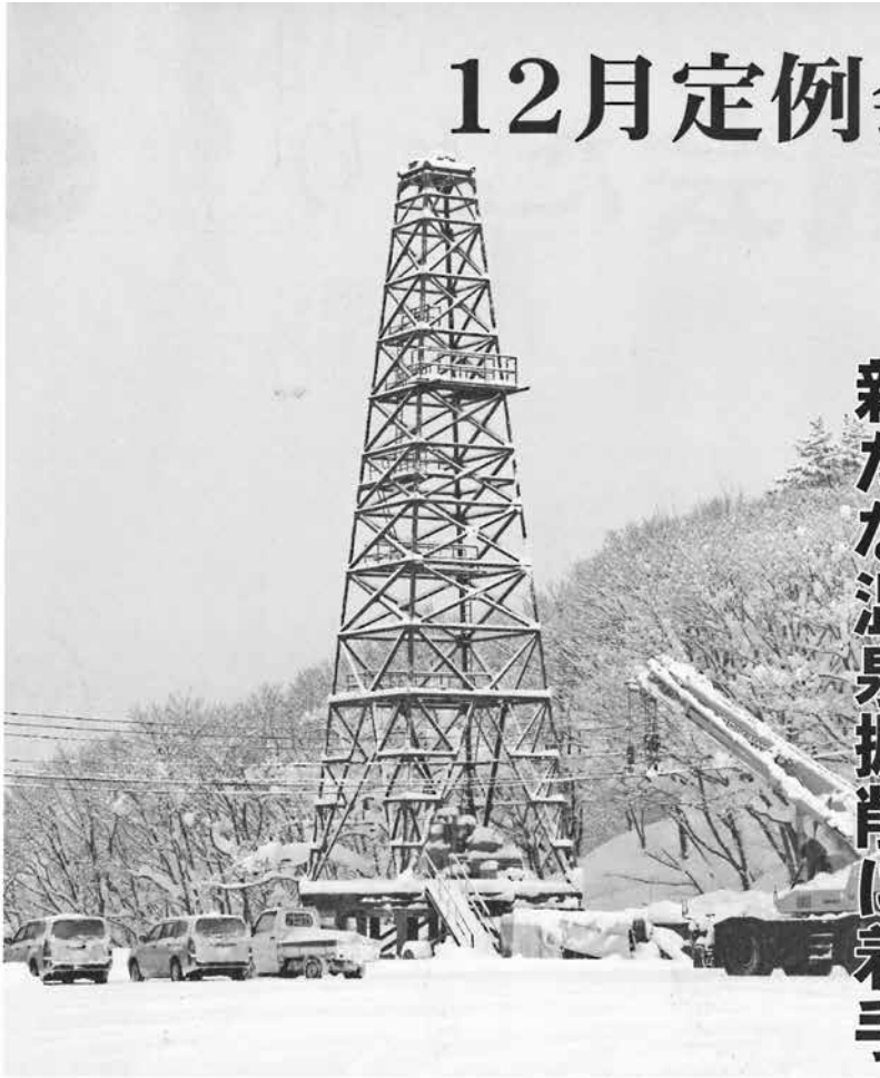
ボーリングの「やぐら」が建った工事現場
