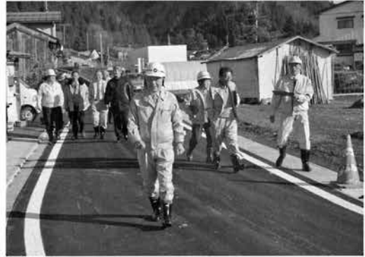
村道改良工事(平良地区)
