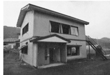
解体が決まった平良生活センター
