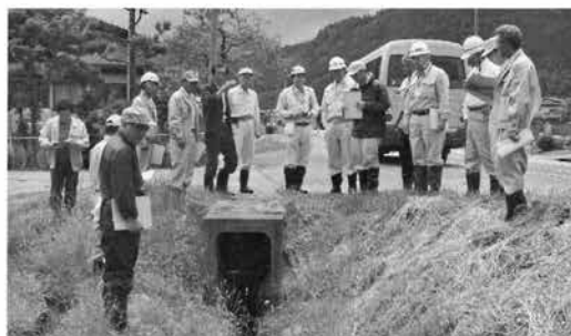
U字溝蓋の設置（滝ノ沢）
