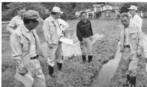
水路改修（手倉）
