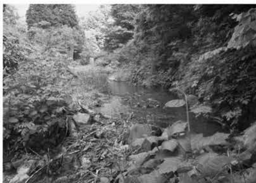
生活用水路の改修（間木・重里台）
