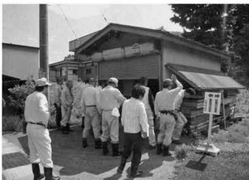
消防ポンプ小屋の改修（五里台）
