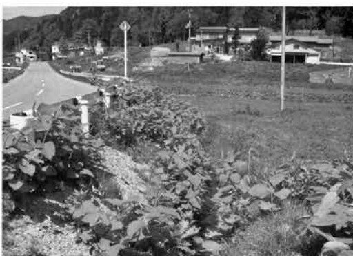
水路の改修（大柳）
