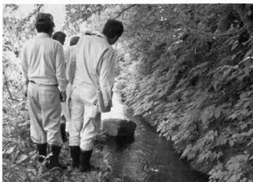
用水路の改修（岩井川・野頭）
