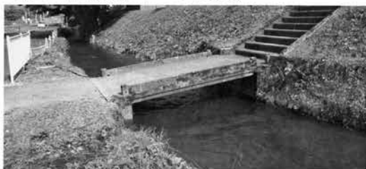
伊達堰の改修に着手
