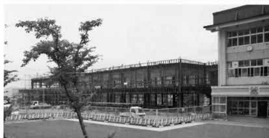
建設中の統合保育所
