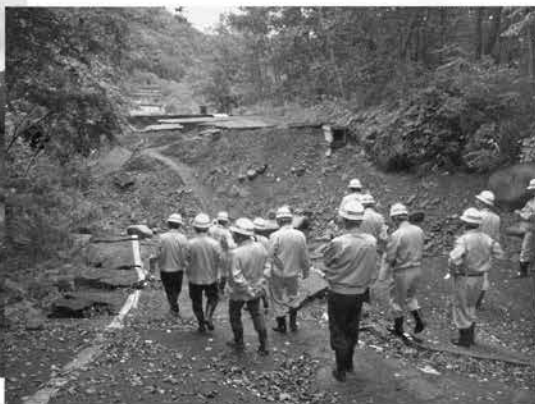
地震直後の姿を残す被災箇所
