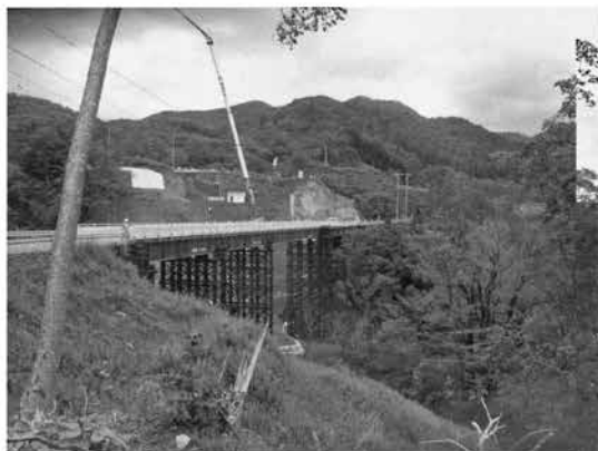
完成した仮橋。工事関係車両が絶え間なく通行していた。
