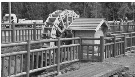
新エネルギーとして期待されている小水力発電
