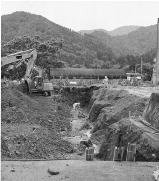
いよいよ着工 村民体育館建設工事
