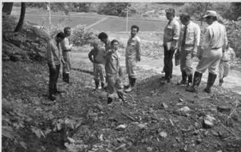
通称アンテナ道路の改修（蛭川）
