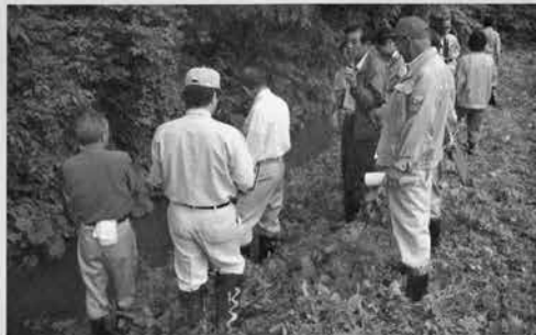
小貫山堰のずい道補修（滝ノ沢）
