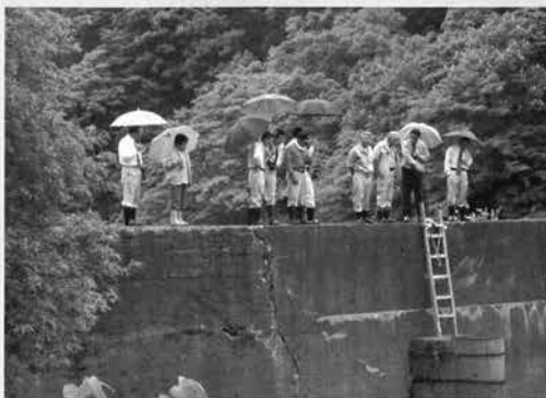
取水口を暗きょに（草の台）
