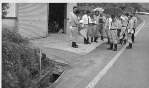
農道にフタ付き側溝の設置を（手倉）
