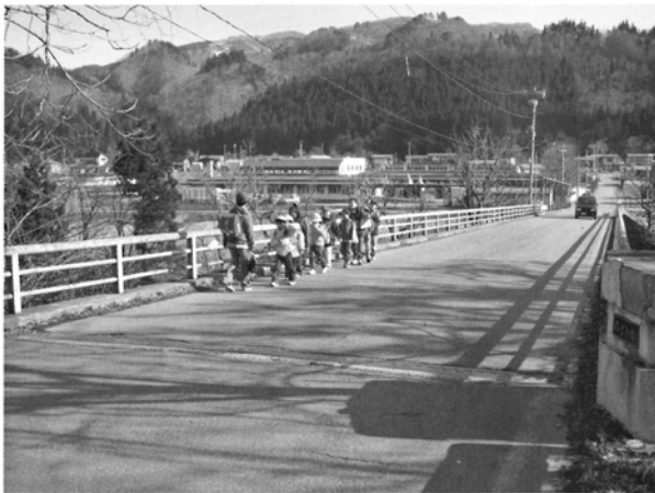
19年度はのぞき橋を改修
