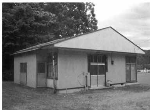
水回りの改修等をする菅生田集会所
