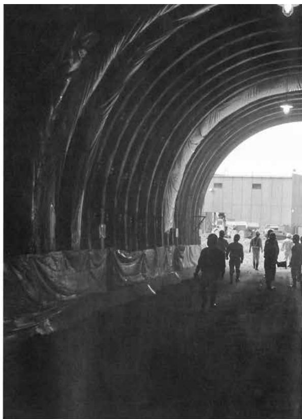
順調に進むトンネル工事
