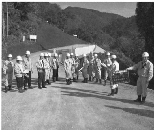
成瀬ダム国道代替進入路工事現場の視察
