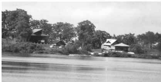
東屋などの修繕（須川湖）
