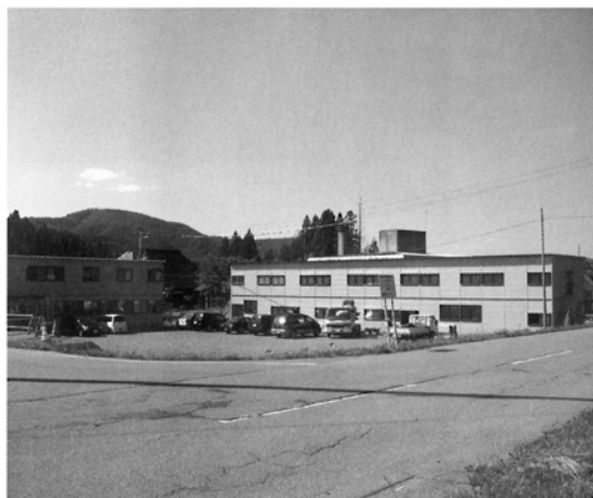
成瀬ダム建設工事業者の現場事務所が完成 (旧大柳小学校敷地内に)
