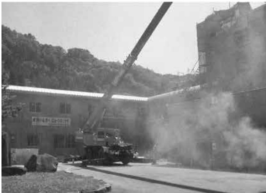
中学校校舎棟の改造工事
