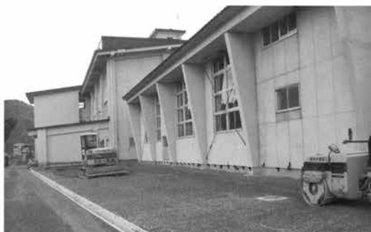
小学校校舎後側の環境整備
