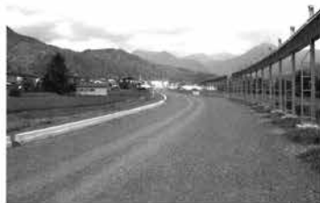
順調に進む岩井川バイパス工事
