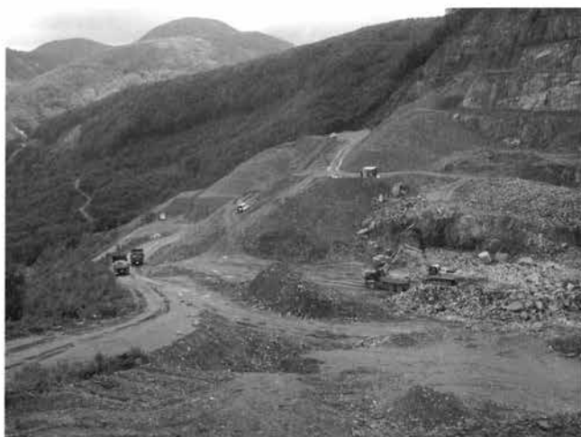
土倉地区の採石作業現場
