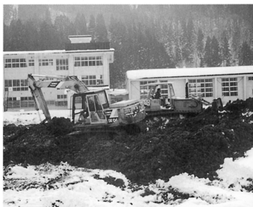
グラウンド造成工事
