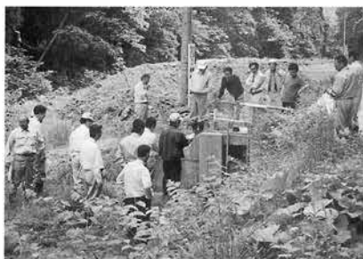
滝ノ沢内堰取水口の視察
