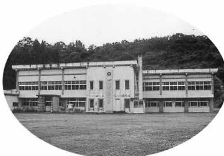
地域間交流施設として生まれ変わる旧樺川小学校校舎
