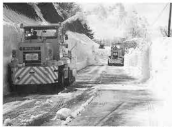
急ピッチで進む除雪作業(狐狼化地区)
