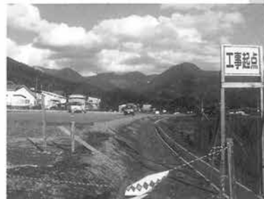
岩井川バイパス工事
