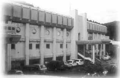
庁舎玄関改修予定
