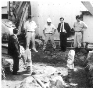
浄化槽工事（滝ノ沢）
