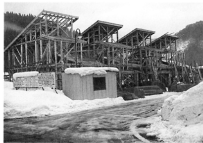
工事中の村営住宅 (平良)
