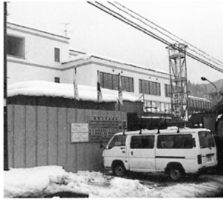
工事中の防災情報センター
