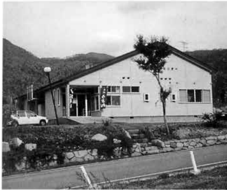
ジュネス休養センター、ボイラー交換を実施
