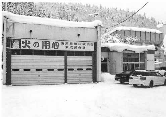
改築される予定の東成瀬分署
