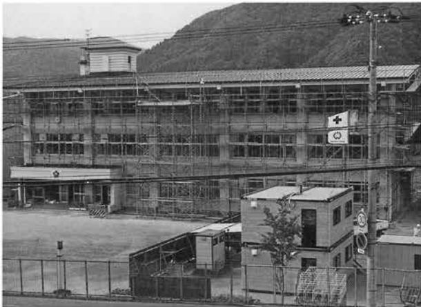
東成瀬小学校改修始まる
