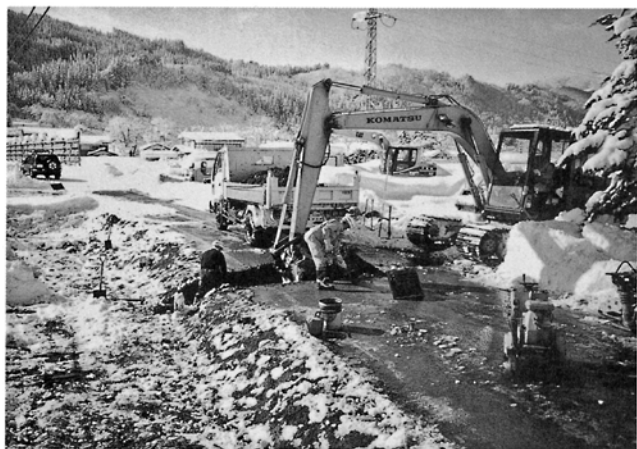
田子内簡水の工事
