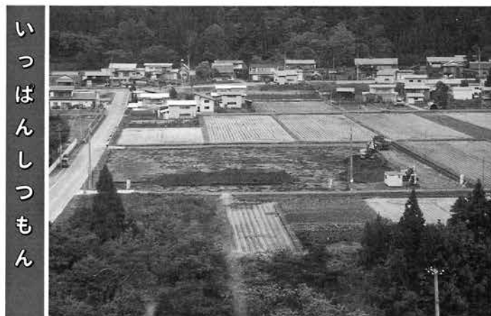
村営住宅の造成工事
