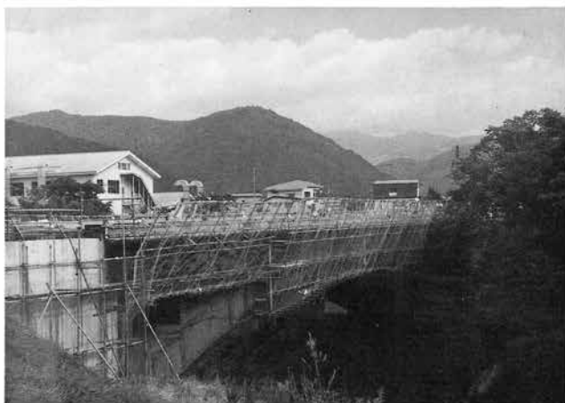
本年11月に通行予定で急ピッチに工事が進む (田子内バイパス・橋工事)
