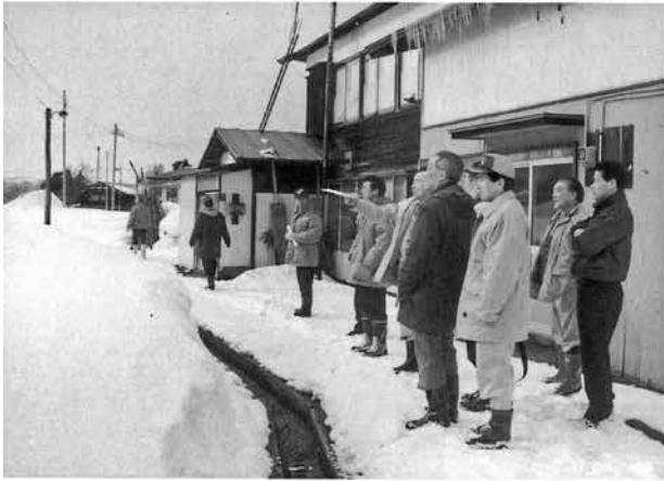
除雪状況について田子内を視察
