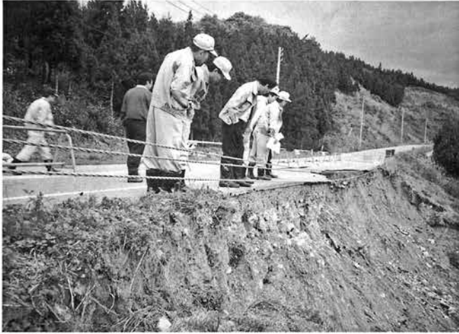
林道の路肩崩落現場なども視察した
