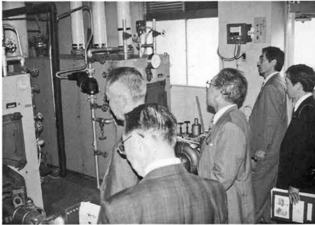
中学校のボイラーを視察する議員たち
