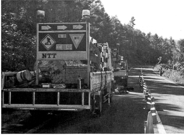
天ヶ沢付近で行われている電話工事
