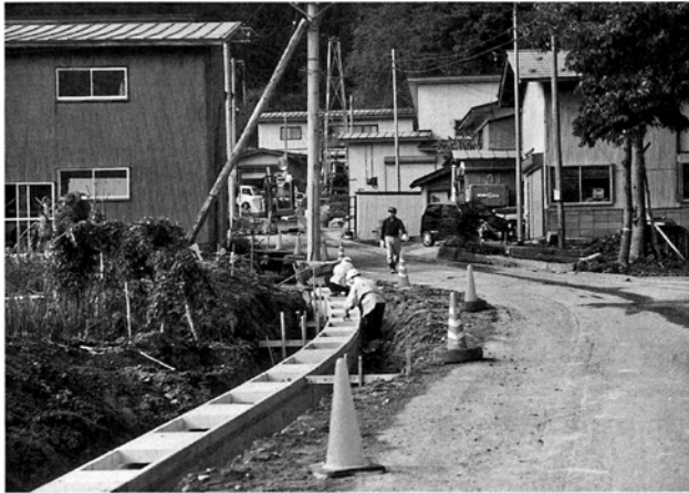
岩井川地内で行われている消融雪工事
