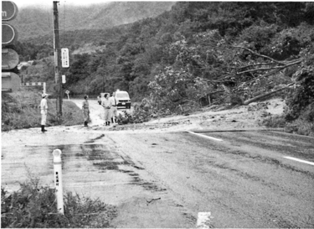
豪雨による土砂の崩落
