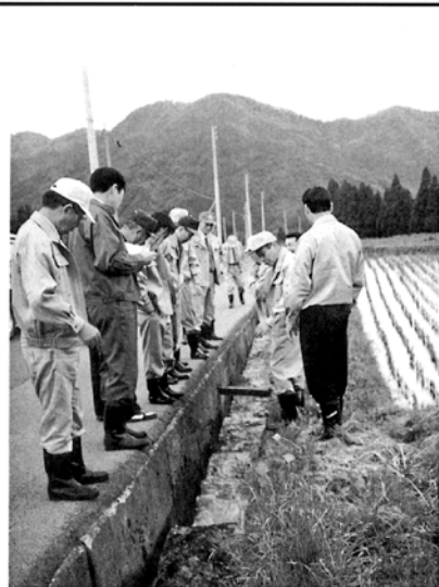
側溝の整備も要望が多い
