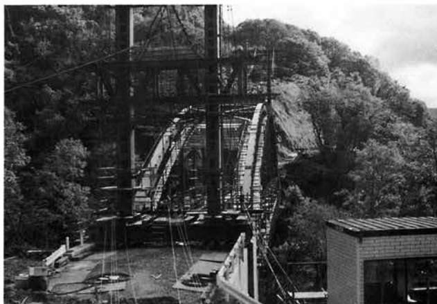
橋を架設中の林道間木谷地線
