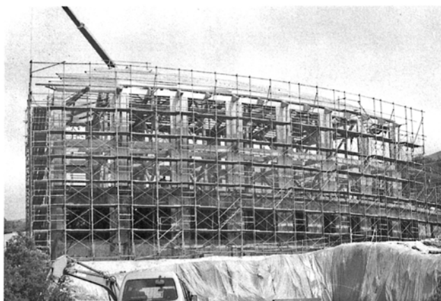
急ピッチの栗駒山荘新築工事
