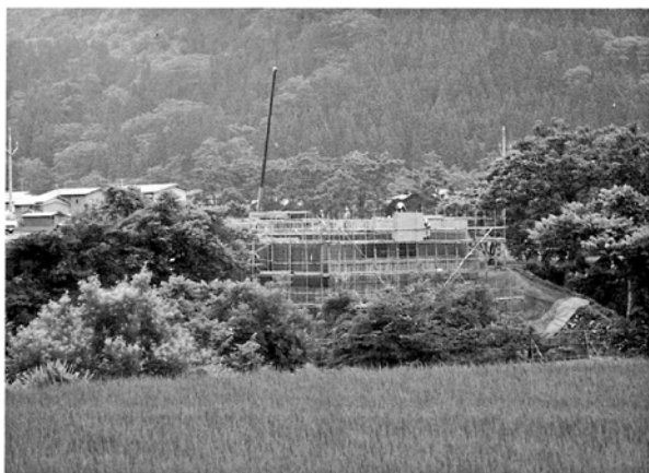
田子内橋左岸の橋台工事
