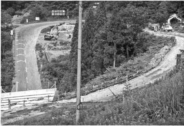
防雪対策が進む国道397号 (沼又地内)
